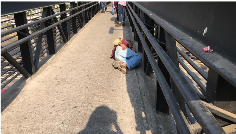
FIGURA 5. PERSONA SIN HOGAR EN PUENTE PEATONAL PARA ACCEDER AL METROBÚS. FEBRERO 2021
